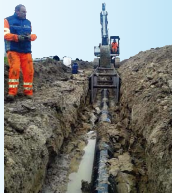
La posa di alcune tubazioni
